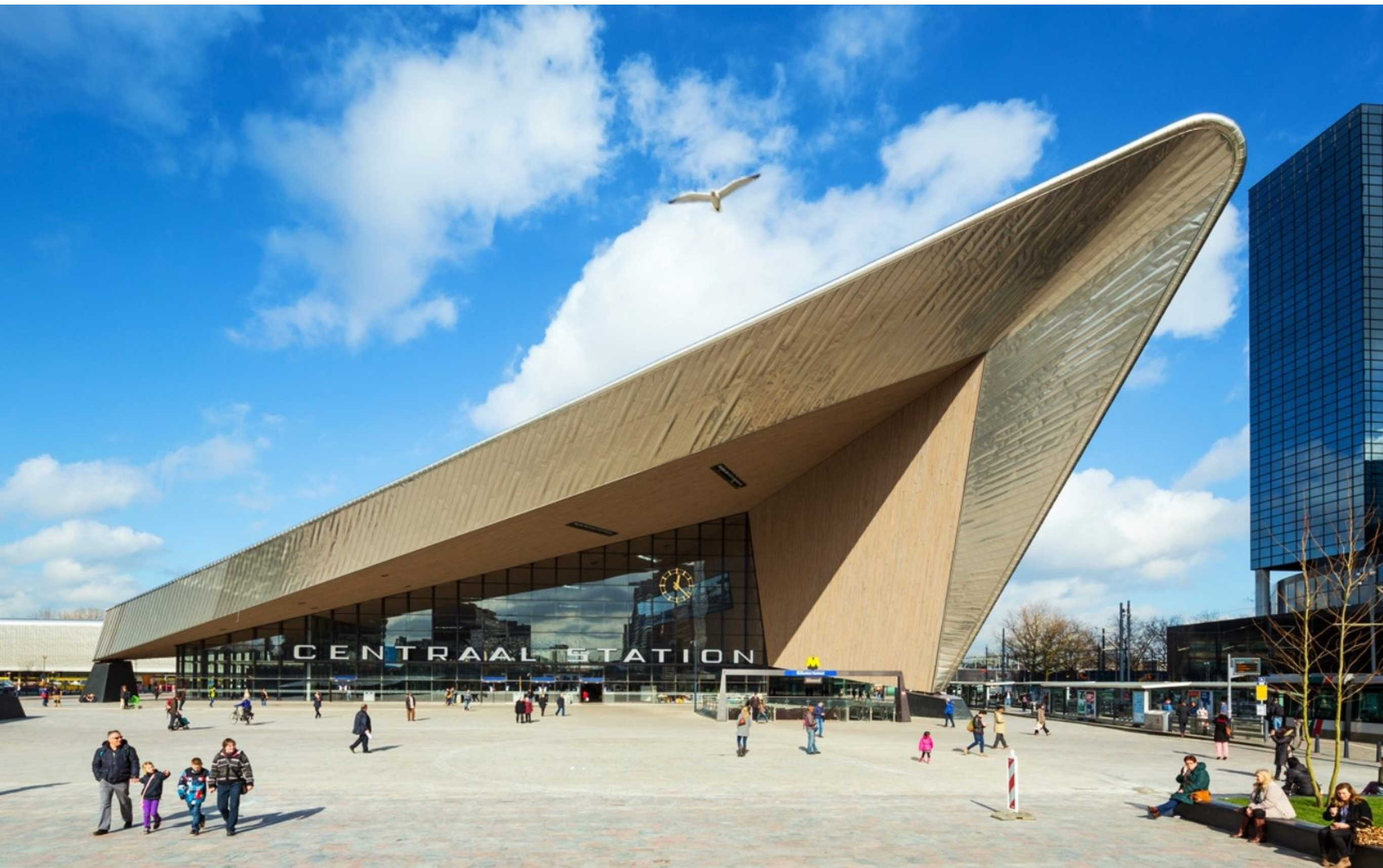
Estación de Rotterdam (NL)
