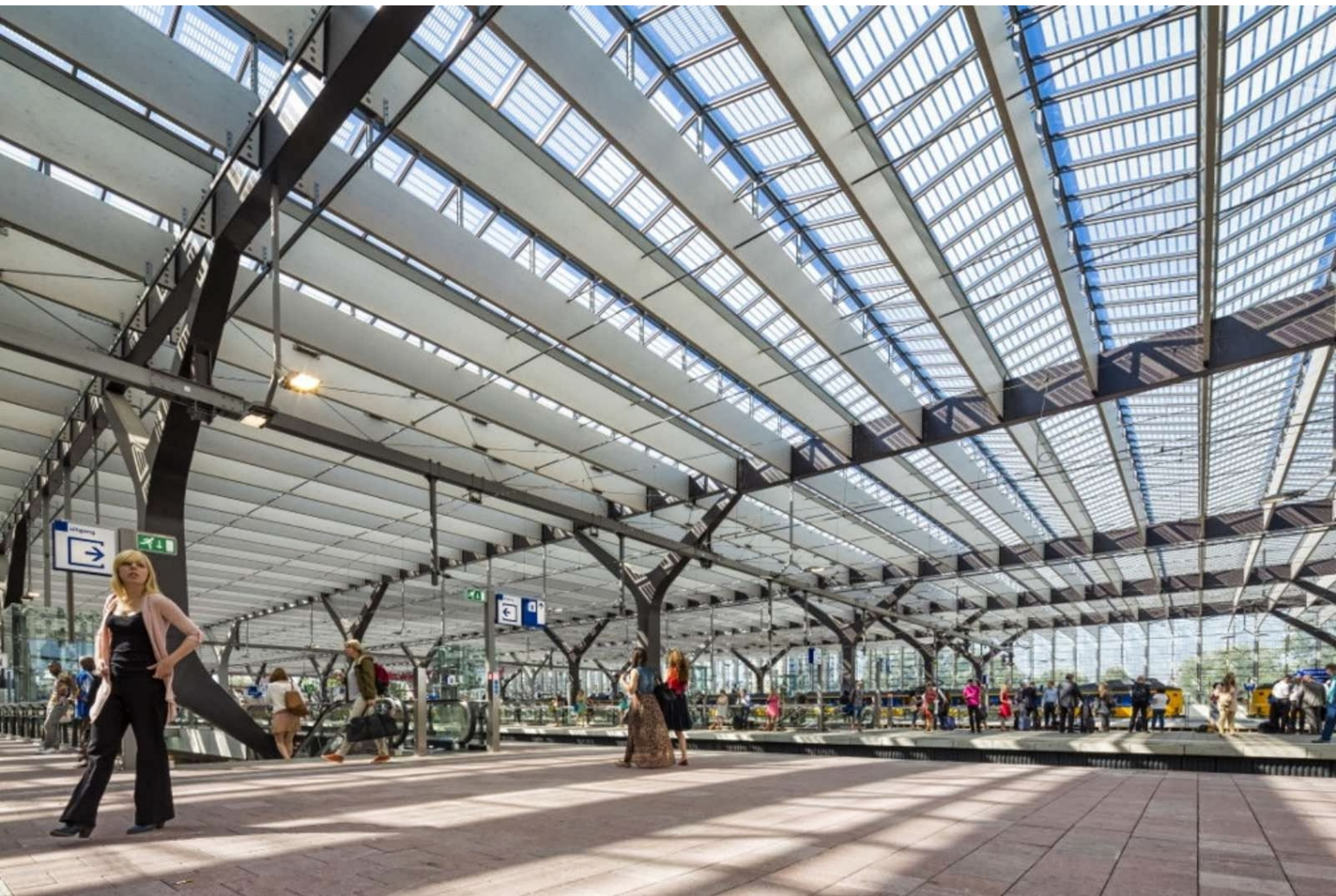
Estación de Rotterdam (NL)
