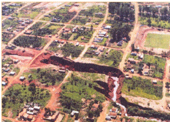
Figura 3.6 Erosão urbana (Campana, 2004)
