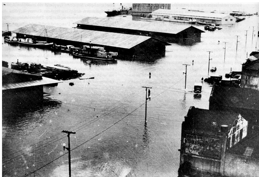
Figura 6.9 Inundação de 1941 em Porto Alegre.
