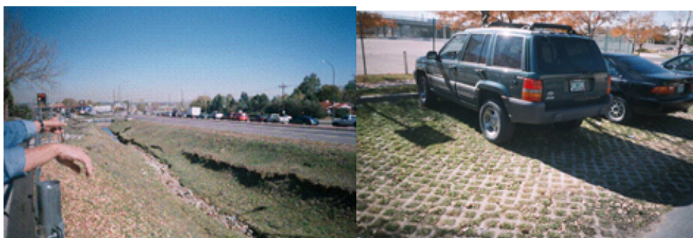
Figura 3.23 Foto da esquerda mostra exemplo de Valo de infiltração e foto à direita pavimento permeável com blocos vazados em estacionamento.
