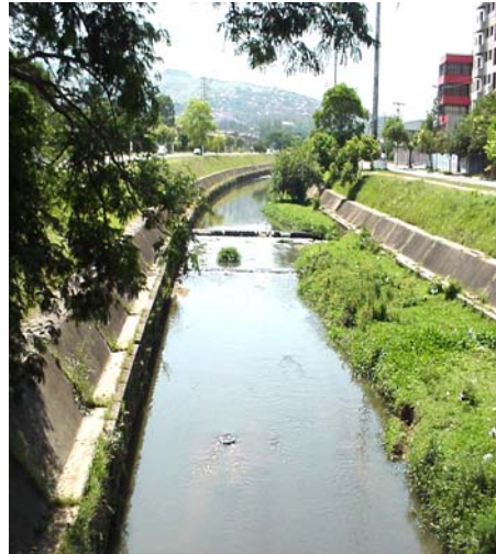
Figura 3.9 Obstruções ao escoamento em canais (Porto Alegre).
