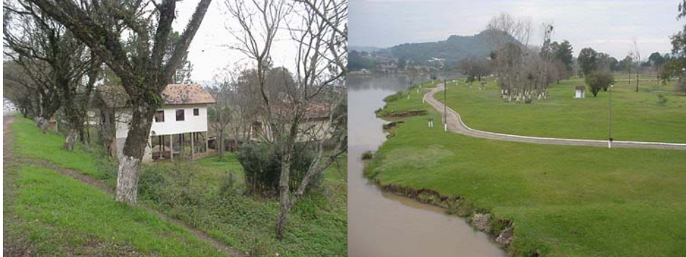
Figura .6.5: Casas com palafitas para conviver com as cheias. Aproveitamento da planície de inundação para parque.
