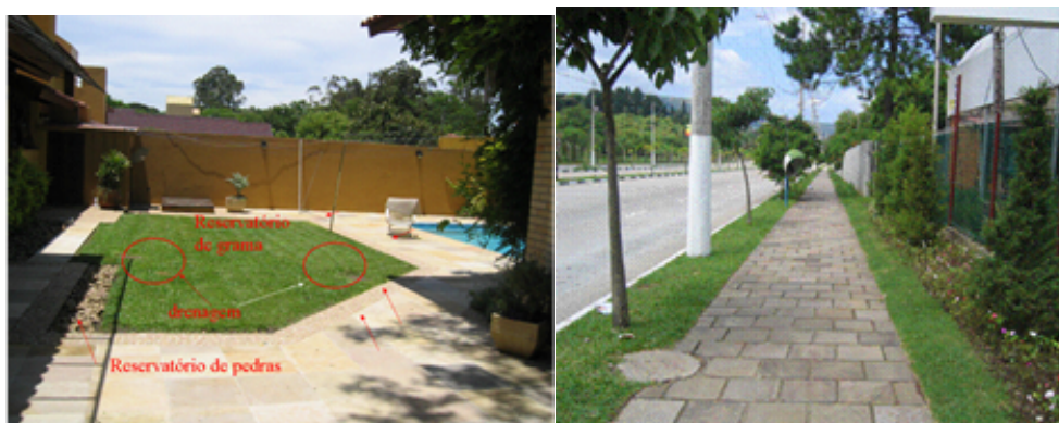
Figura 3.22 Uso de dispositivos para reter a água de áreas impermeáveis (a) foto da esquerda mostra as áreas drenadas de pavimentos para o gramado e dos telhados para reservatórios de pedra: (b) calçadas com grammas laterais para aumentar a infiltração.
