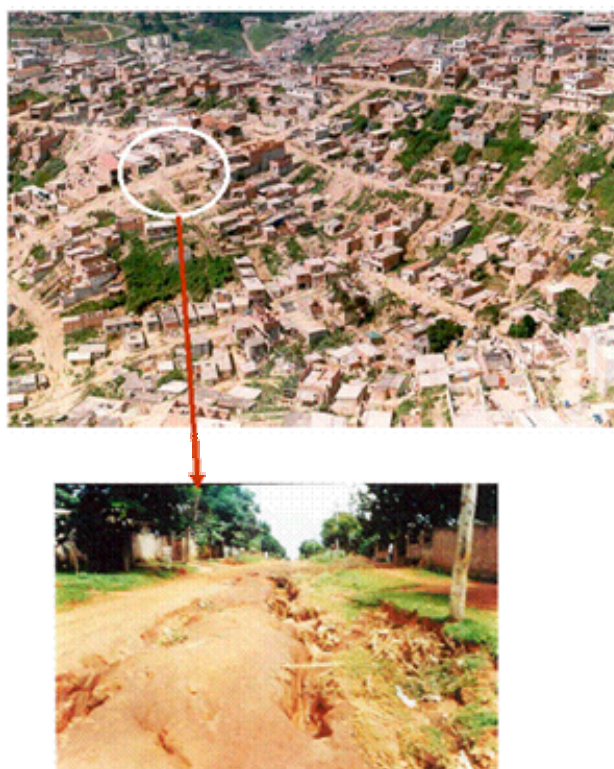
Figura 3.5 Erosão urbana (Campana, 2004).
