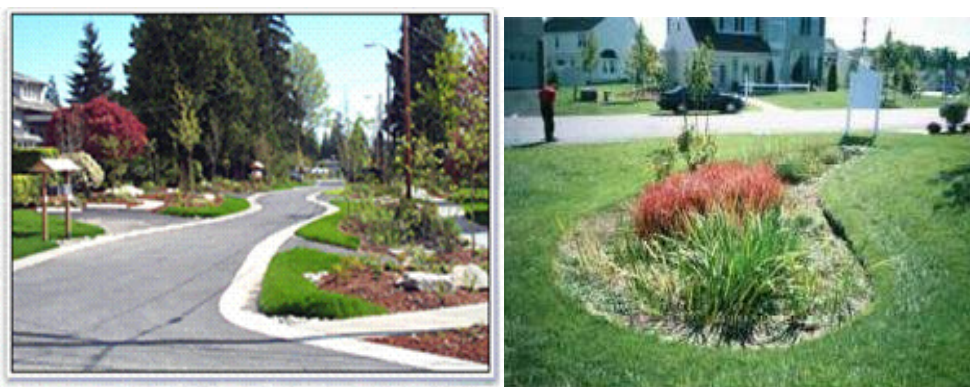
Figura 3.24 Foto da esquerda mostra rua sem meio fio que permitem a infiltração de parte do escoamento nas laterais gramadas. Na foto da direita é apresentada uma área de infiltração num canteiro (incluir fonte).
