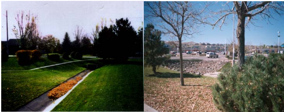
Figura 3.29 Armazenamento num condomínio (esquerda) e no estacionamento de uma área comercial (direita).
