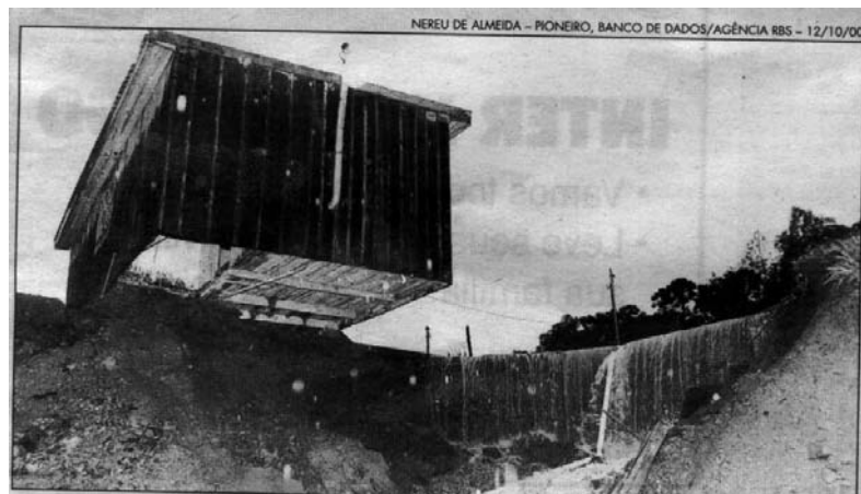
Figura 3.11 Ocupação em áreas de risco
